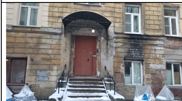
Фото 13. Вид общего входа Объекта оценки со двора
